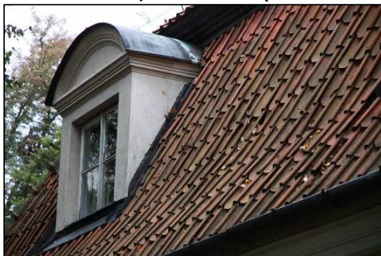
Fot. 29 Pokrycie daszku lukarny w połaci wschodniej
