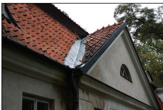
Fot. 23 Ubytki dachówki przy koszu pseudoryzalitu
