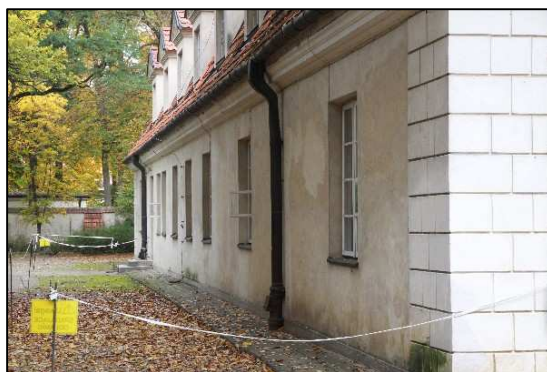
Fot.34 Podłączenie rur spustowych do kanalizacji deszczowej
