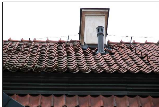
Fot. 30 Nieszczelne obróbki blacharskie wywiewki wentylacyjnej
