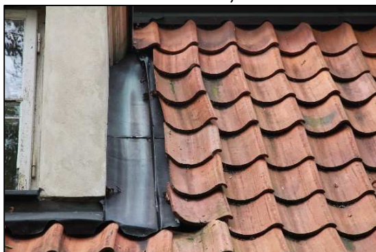
Fot. 31 Obróbka ścian lukarny
