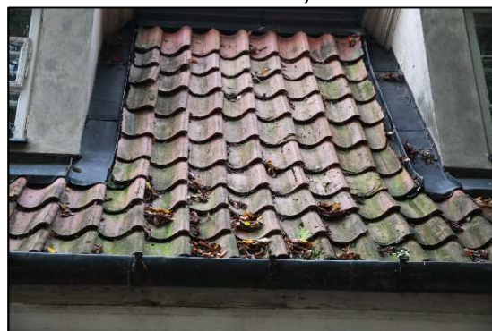
Fot. 28 Obróbki blacharskie ścian bocznych lukarn
