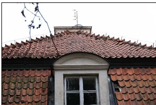
Fot. 25 Przemieszczenia dachówek na połaci północnej
