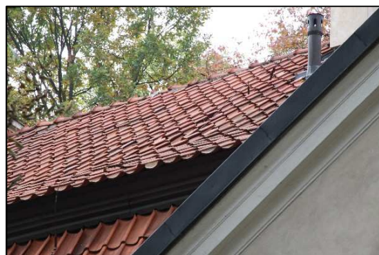
Fot. 26 Obsunięcia dachówek na połaci wschodniej
