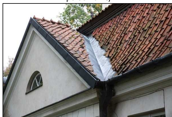
Fot. 24 Braki dachówki i zniszczenia obróbki kosza
