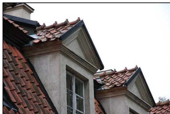
Fot. 20 Ubytki dachówki na daszkach lukarn
