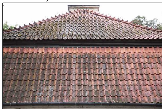
Fot. 22 Zmurszałe dachówki na połaci południowej
