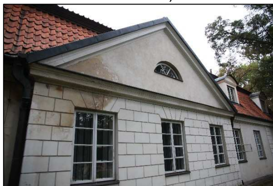
Fot. 36 Zacieki na ścianach pseudoryzalitu
