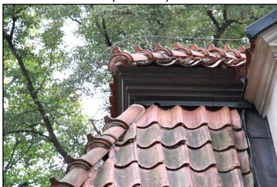
Fot. 27 Obróbka blacharska połączenia połaci strychu z mansardą
