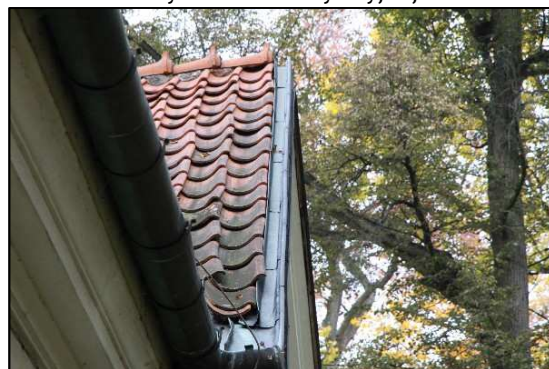
Fot. 32 Obróbka szczytowa pseudoryzalitu
