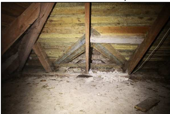
Fot. 13 Połączenie daszku lukarny
