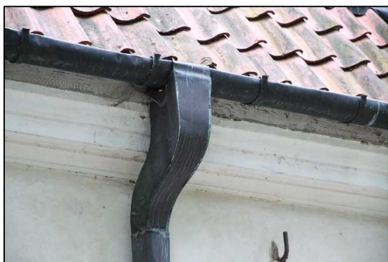
Fot. 33 Odprowadzenie wody z rynny do rury spustowej
